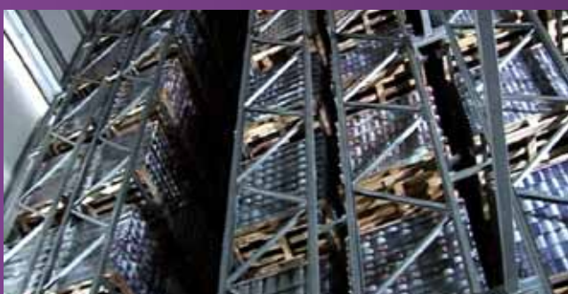
Logistický sklad na prázdné plechovky ( 7000 palet)
